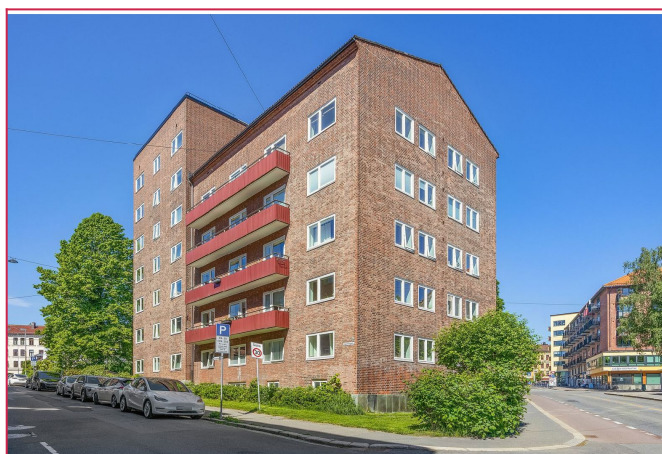
Det finnes 17 biloppstillingsplasser i bakgård, hvorav 10 har elbil-lader.
