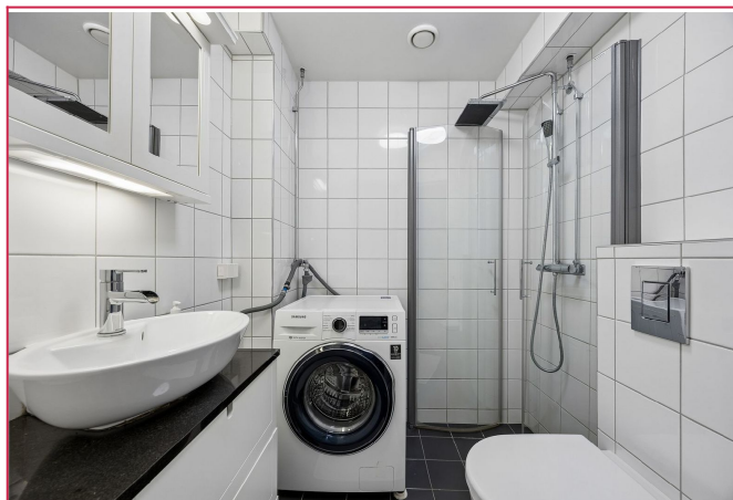
Flislagt bad med gulvvarme og vaskemaskin.
