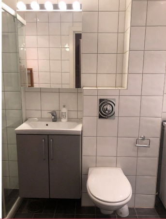
Flislagt bad med varmekabler.
