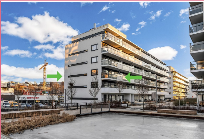
Fasade - leiligheten ligger i 3. etasje
