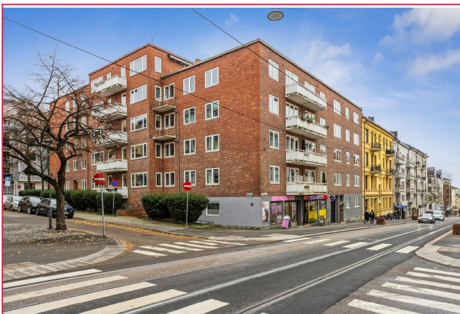
Bygningens fasade – klassisk og velholdt med en attraktiv beliggenhet på Adamstuen.
