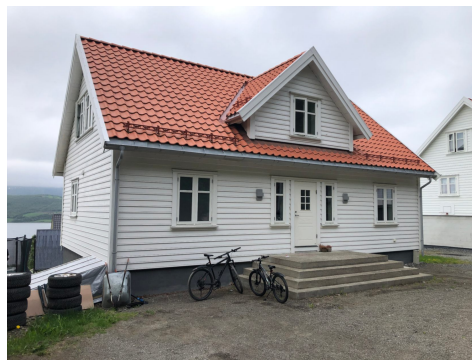
Bildet viser hovedinngangsdør.
