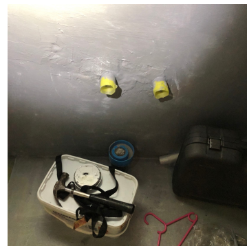
Membranarbeider påbegynt, ikke ferdigstilt.
