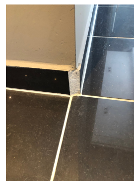
Manglende fugemasse og bom i flis.
