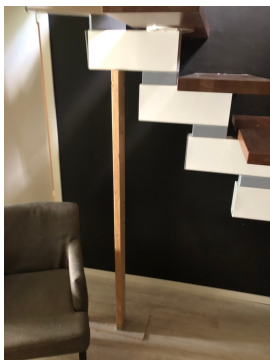
Provisorisk understøttet med planke i gulv.
