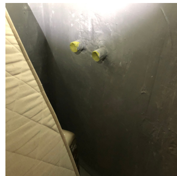
Membranarbeider påbegynt, ikke ferdigstilt.
