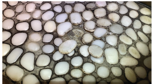
Flere løse steiner på gulv.
