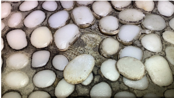
Usikkerhet rundt tetthet på membran.
