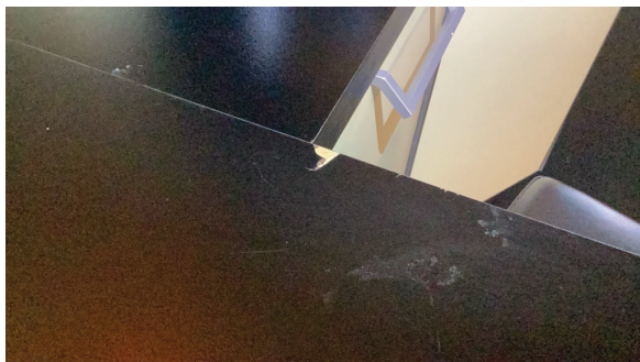
Sår i benkeplate.
