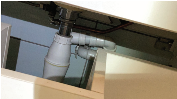
Utett rundt gjennomføring i våtsone.
