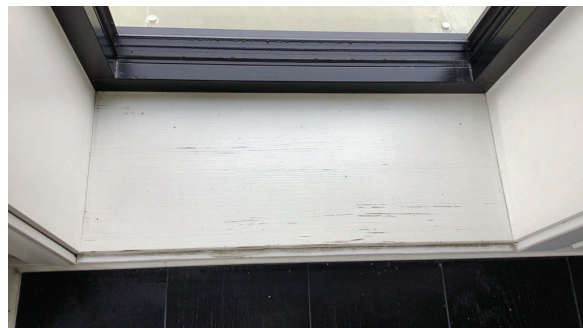
Slitasje i utforinger.
