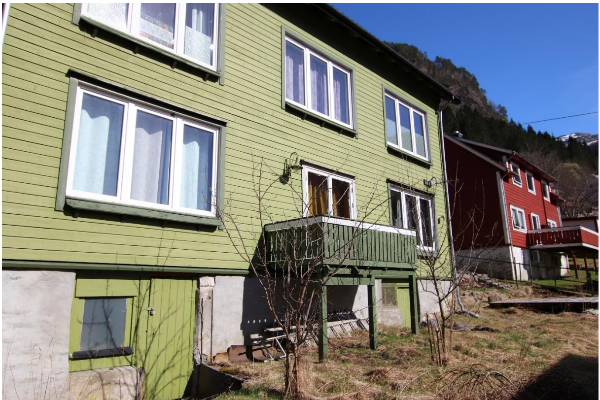
Inngang til kjellerbod på baksiden av bygget
