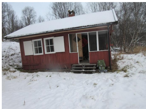
Fasade med inngangsparti
