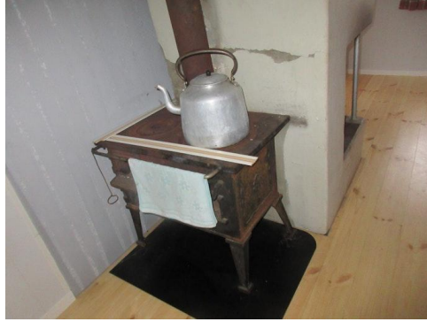
Vedovn, merk riss i puss/pipe
