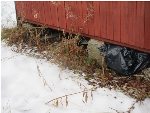
Fundamenter av betongpeler, avretting/justering med trekiler
