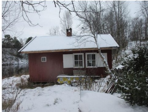
Snø på taket ved befarung.
