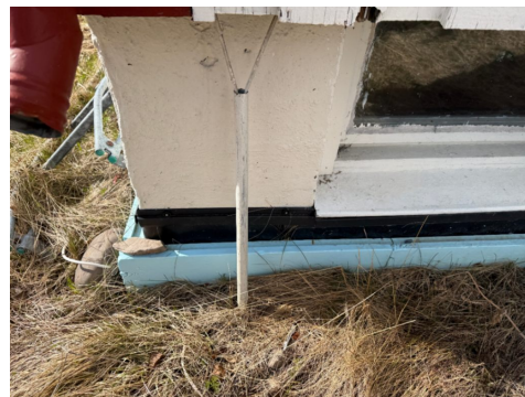
Synlig isolasjon utenpå grunnmursplasten
