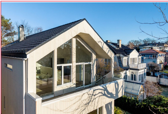
Fasade balkong | Vendt mot sør som gir gode solforhold
