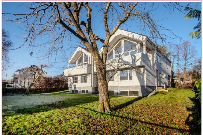
Hage | Tilbaketrukket og solrik
