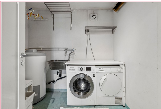
Praktisk vaskerom/teknisk rom med opplegg for vaskemaskin, samt innvendig bod i underetasjen.
