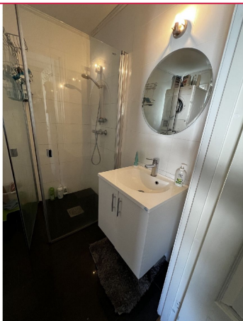
Bad i første etasje
