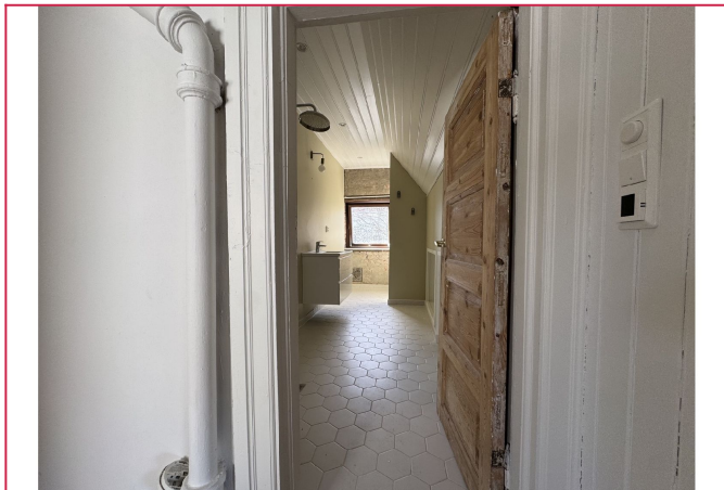
Bad i andre etasje - opplegg til vaskemaskin i knevegg.
