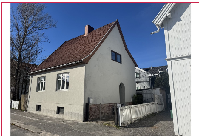
Fasade - fasaden er nylig pusset opp og flere vinduer er byttet.
