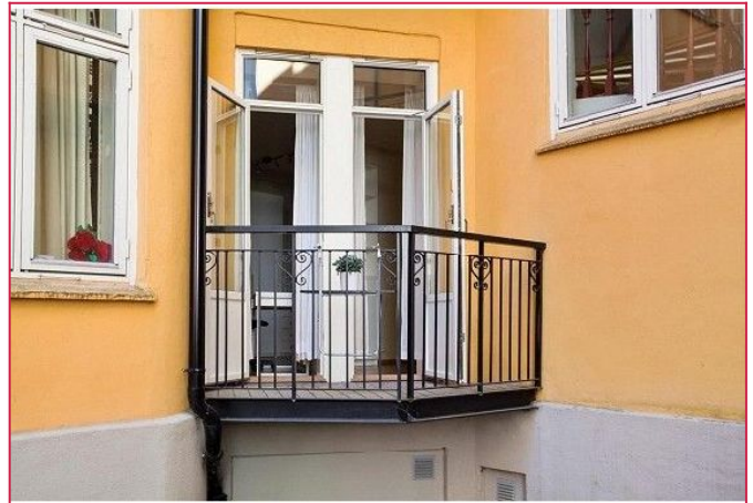
Hyggelig balkong mot bakgård
