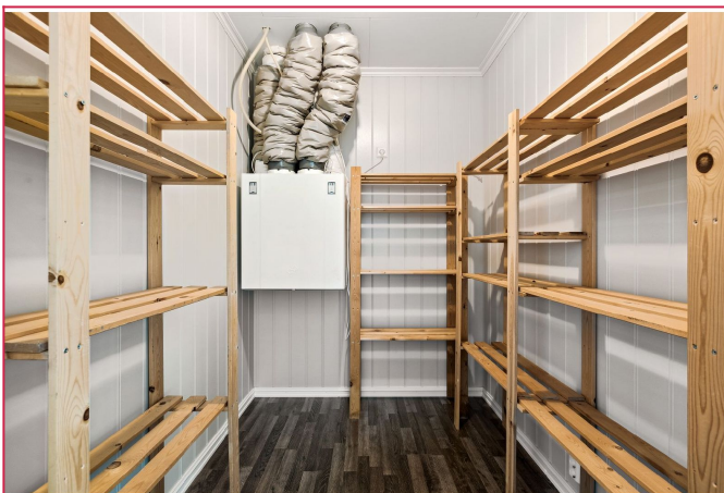
Innvendig bod / teknisk rom
