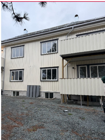
Velholdt fasade med store vindusflater som sikrer godt lysinnslipp
