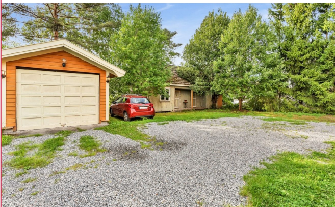
Biloppstillingsplass med garasje.
