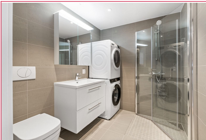
Flislagt bad med varmekabler med tilhørende vaskemaskin og tørketrommel
