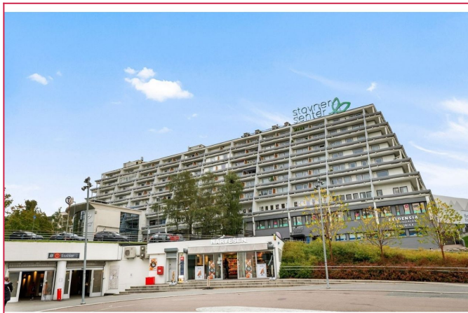
Fasade. T-bane og buss i umiddelbar nærhet.
