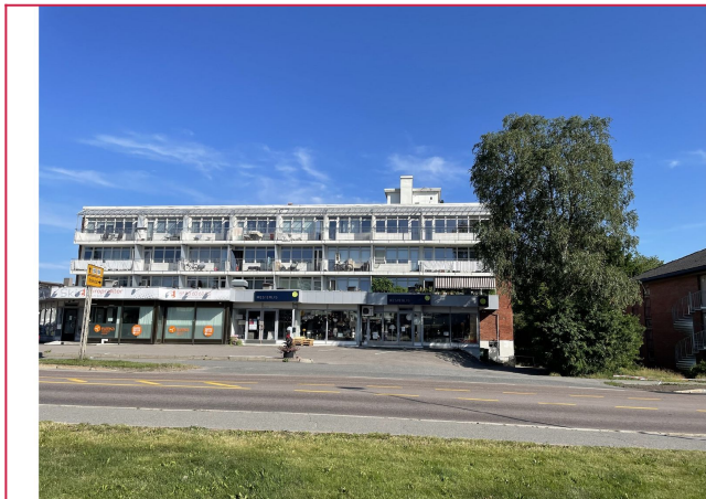
Leiligheten ligger i 4. etasje i enden og har langsgående balkong.
