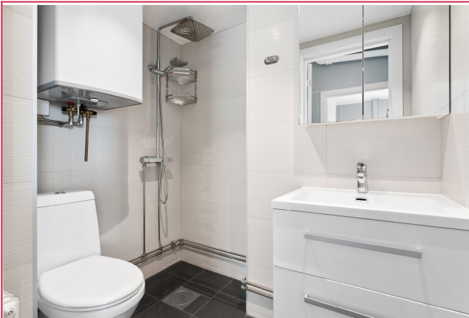
Flott flislagt bad som har varmekabler.
