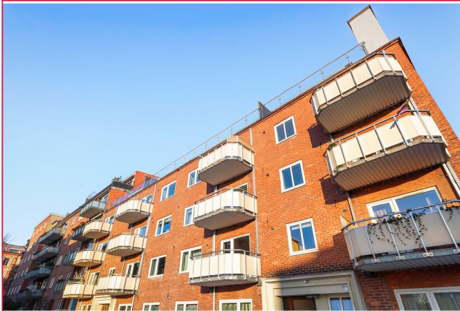
Leiligheten ligger i øverste etasje på bildet, 4. etg.
