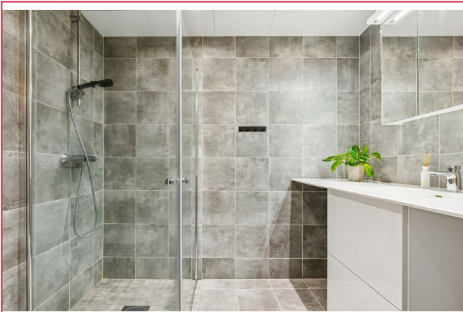
Flislagt bad med dusjhjørne. Opplegg til vaskemaskin på bad.
