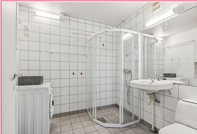
Flislagt bad med varmekabler.
