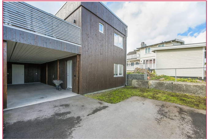
Lang carport og dør inn til sportsbod
