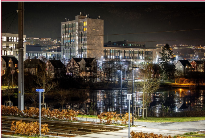
Områdebilde med bybanespor, Solheimsvannet, Inndalsveien 23 og HVL
