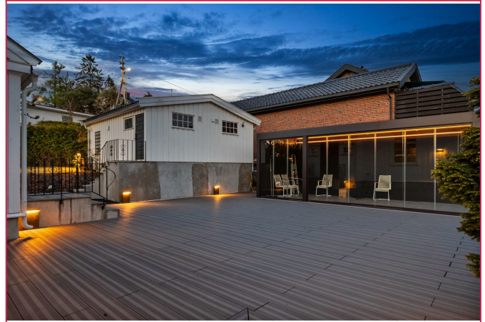
Pergola tilrettelagt for helårsbruk med varmekabler.
