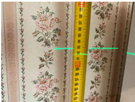
Måling av planavvik gjennom hele rommet, loftsetasjen
