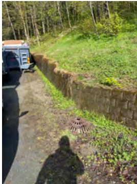
Forstøtningsmur langs innkjørsel.
