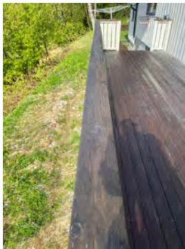
Påbegynte råteskader i terrassedekket
