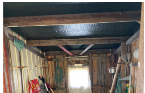
Undertak av pressening.
