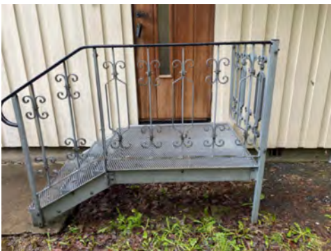
Trapp i strekkmetall som hovedtrapp.
