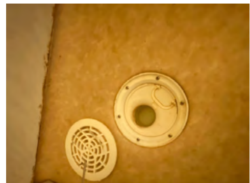
Sluk i dusjsonen.
