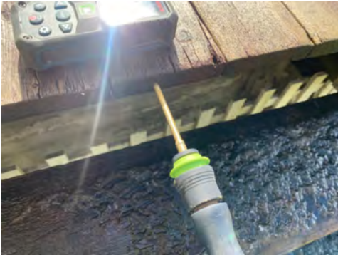
Påbegynte råteskader i terrassedekket
