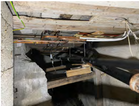
Vannrør i kobber med plastkappe.
