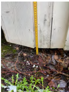
Påbegynt råteskade i nedkant av kledningen.
