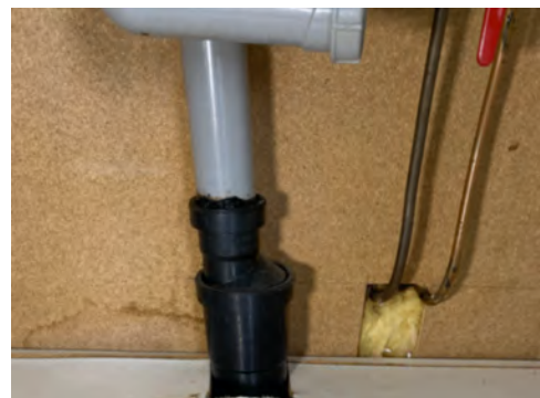
Bruk av tettemasse rundt avløpsrør.
