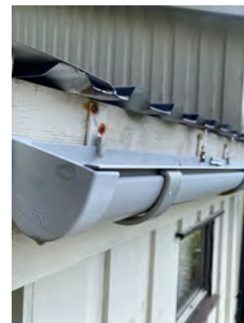
Det ble observert rust i nedkant av platene.
