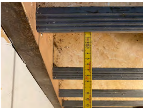
Trapp med nedgang til kjeller.
