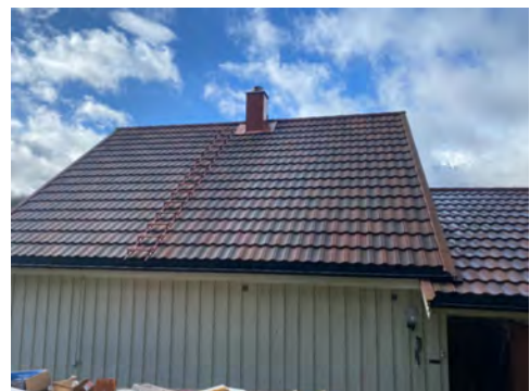
Yttertak fra ca. 2010.
