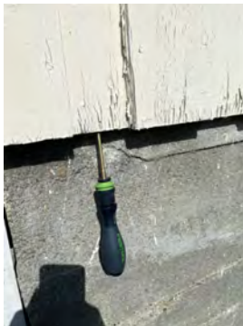
Påbegynt råteskade i nedkant av kledningen.
