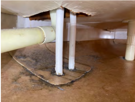
Vannrør i kobber med plastkappe.
