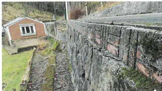
Eksempel på forstøtningsmur uten sikring
