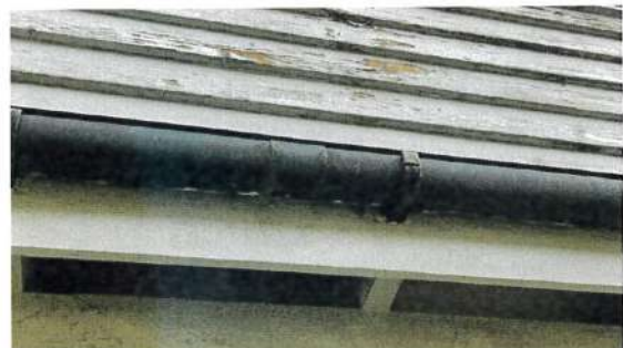
Rustskade rennekroker
