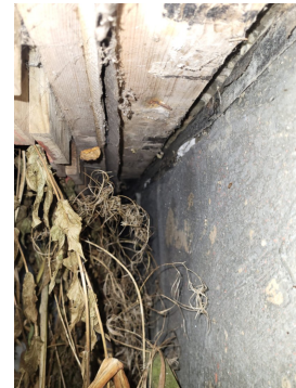
Bilde utvendig mot mur. Grunnmuren ligger innenfor grunnmuren, Line for vegg ligger utenfor grunnmuren.
