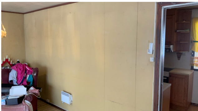
Veggplater i stue.
