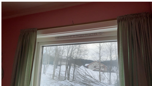
Ventilering gjennom vinduer.
