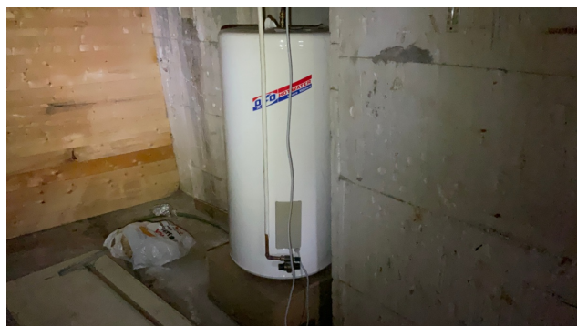
Bereider fra 1995 tilkoblet via stikk-kontakt.
