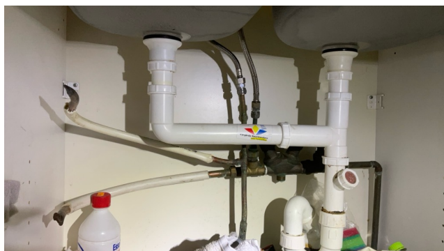
Kontroll av rørsystem.
