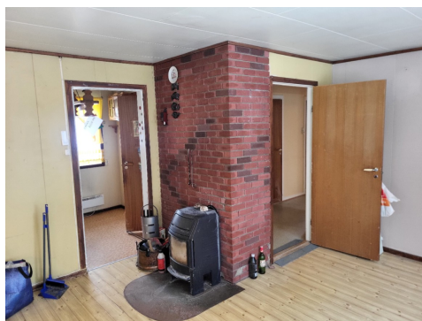
Vedovn med brannmur i stue.
