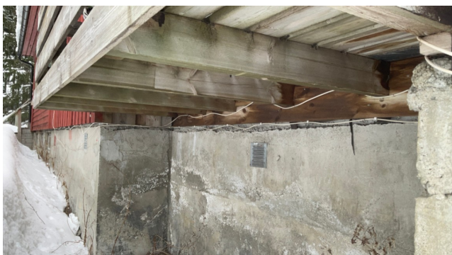
Bjelkelag under balkong mot sørvest.
