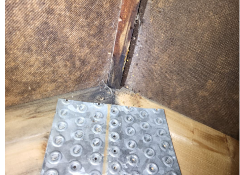
Råteskade på mønekam og taksperre.
