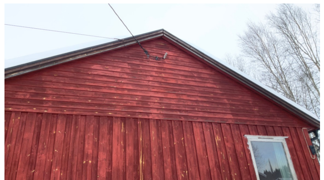
Gavlvegg mot sørøst.
