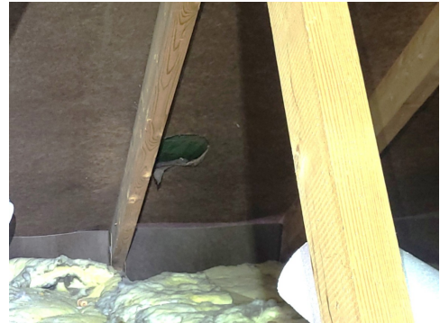
Råteskade på mønekam og taksperre.
