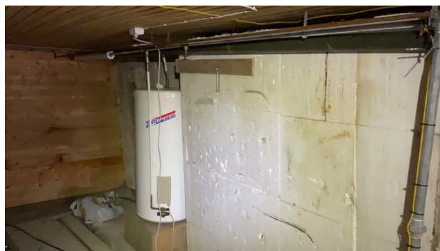
Bereider fra 1995 tilkoblet via stikk-kontakt.
