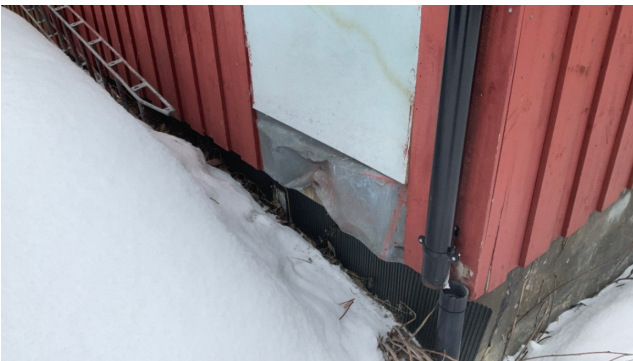
Grunnmursplast på grunnmuren mot nordøst
