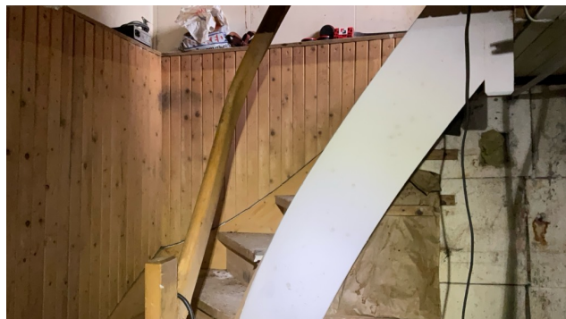
Manglende rekkverk.
