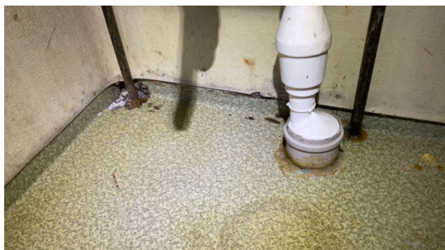
Rørgjennomføringer i gulv.
