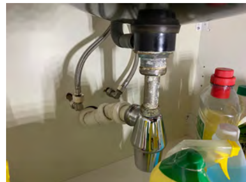
Kontroll av røropplegget.
