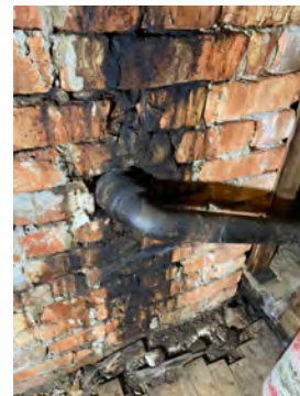
Rennemerker fra sotvann. Manglende murpuss av skorstein over kaldloft.
