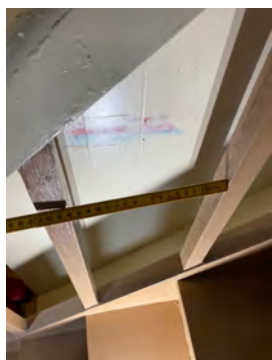
Åpninger mellom trinn, trapp til kjeller.
