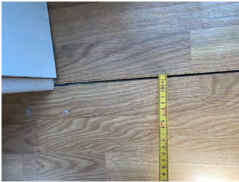
Glippe i skjøte laminatgulv.
