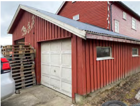
Tak over garasje og inngangsparti.
