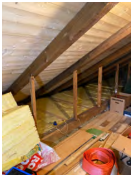
Fuktmåling i takkonstruksjon viste ingen forhøyede fuktverdier.
