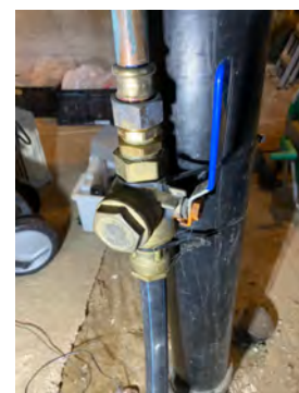
Ikke fagmessig installasjon av vannrør. Manglende rørskap samt endemuffer.
