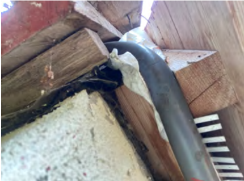
Manglende tetting av hjørnebord samt manglende tetting av musebånd.
