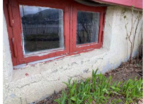
Kjellervindu med koblede glass.
