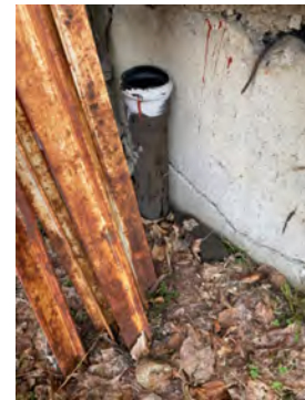
Plastrør mot grunn mot nordvest.
