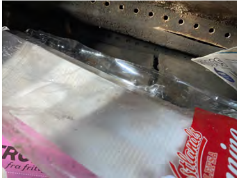
Sprekk i ildfast stein.
