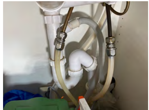
Kontroll av røropplegget.
