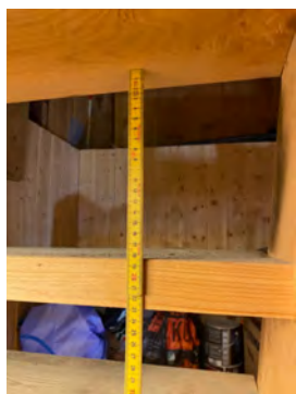
Åpninger mellom trinn, trapp til kjeller.
