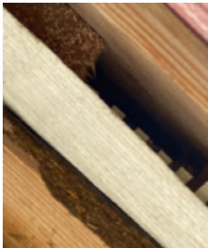
Manglende tetting av hjørnebord samt manglende tetting av musebånd.
