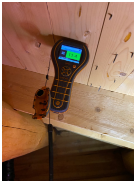
Ingen unormale verdier ved fuktsøk mot trefro.
