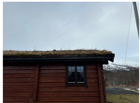
Påbegynt fuktskader vindski -bord.
