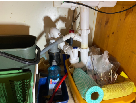
Kontroll av røropplegget.
