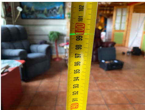
Måling av planavvik
