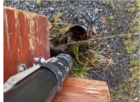
Manglende tilkobling av nedløpsrør til grunn.
