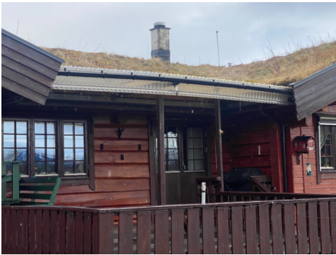
Tak over terrasse.
