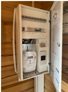
Sikringsskap med automatsikringer.
