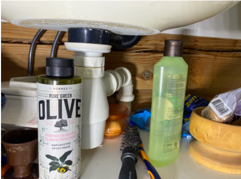
Kontroll av røropplegget.
