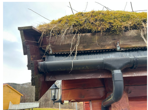
Påbegynt fuktskader vindski -bord.
