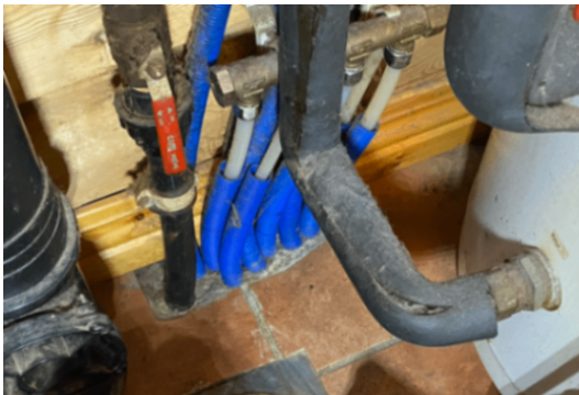
Stoppekrane plassert på tekniskrom.
