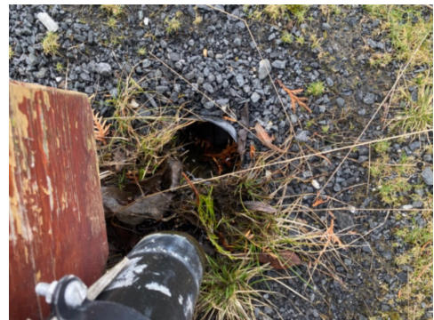
Nedløpsrør for drenering i grunn
