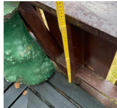
Rekkverkshøyde ca 65 cm
