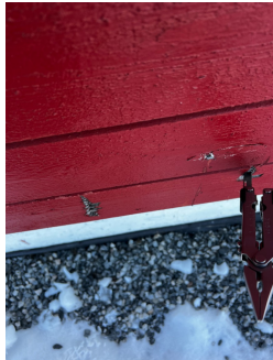
Stikkprøver viser spredte råteskader
