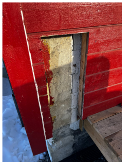
Stikkprøver viser spredte råteskader
