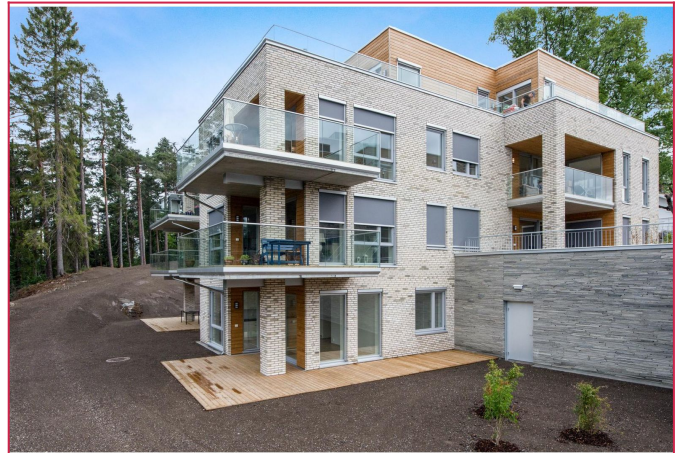
Fasade (før gressplen ble lagt)
