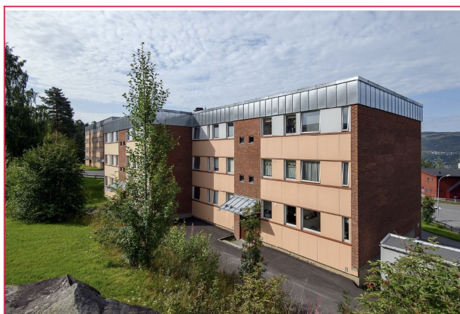
Inngang på baksiden av blokken også.
