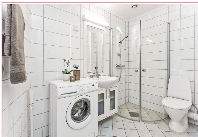
Pent flislagt bad med varme i gulv - det er satt inn dusjkabinett etter bildet ble tatt
