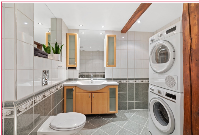
Flislagt badrom med varmekabler i gulv.
