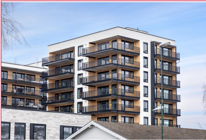
Fasade. 5.etasje i B-blokken.
