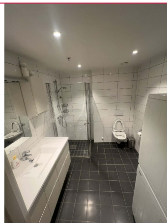
Servant, dusj og vegghengt toalett
