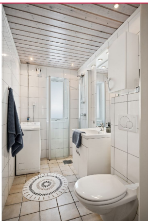
Elektriske varmekabler i gulvet sørger for en behagelig temperatur
