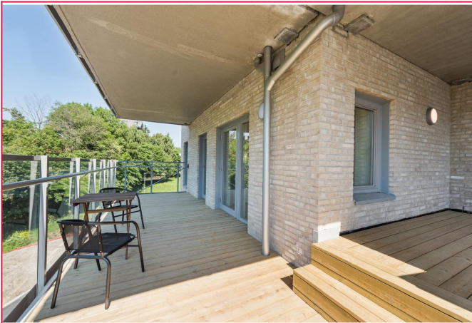
Stor balkong med atrium
