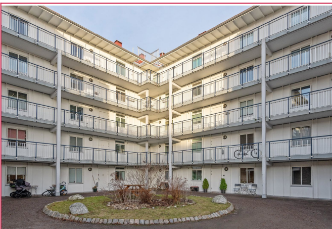
Pent opparbeidet gårdsrom.
