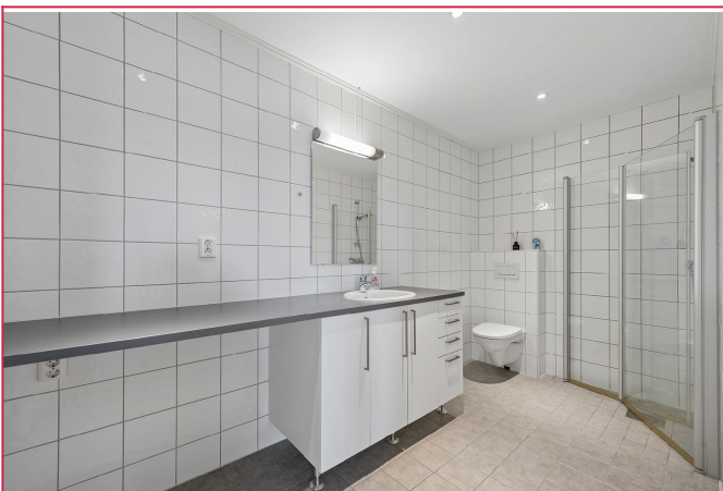
Bad med opplegg for vaskemaskin og tørketrommel.
