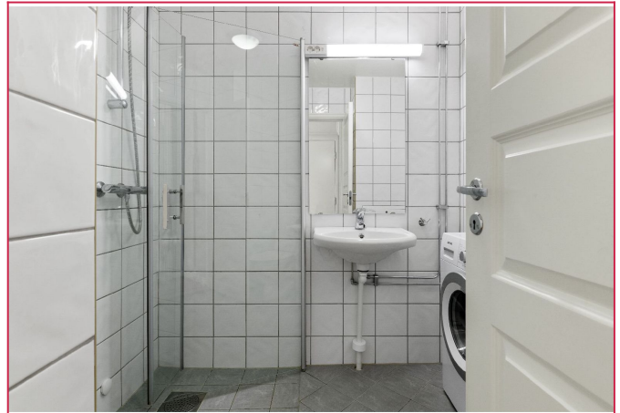
Flislagt baderom med gulvvarme, dusj, servant, toalett og vaskemaskin
