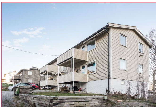
Fasade, leiligheten har en romslig balkong og ligger med nærhet til både Lillestrøm og Strømmen.
