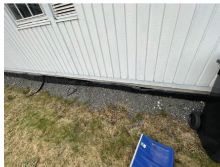
Bildet viser deler av klemlister ved grunnmursplast.
