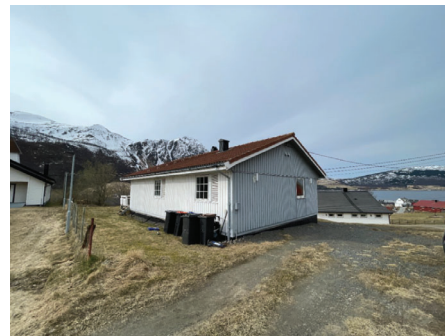
Utvendig oversiktsbilde. Viser deler av taktekking.
