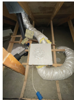
Bildet viser kanalføringer på kaldlft.
