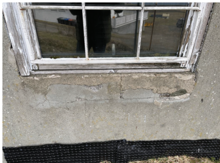
Bildet viser vindu i krypkjeller.
