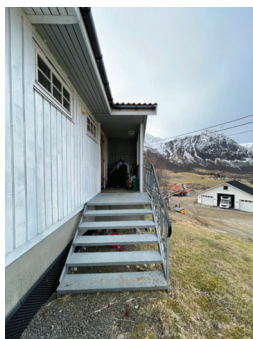
Bildet viser trapp ved hovedinngang.
