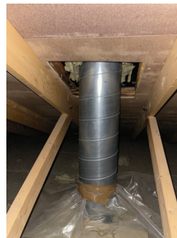
Bildet viser kanalføringer på kaldlft.
