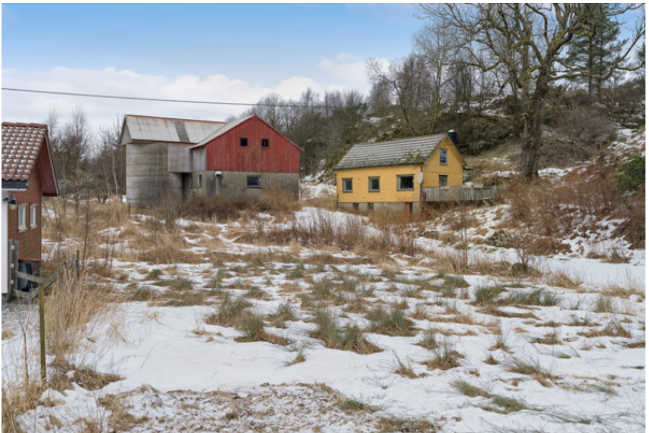
Det må påregnes renovering.
