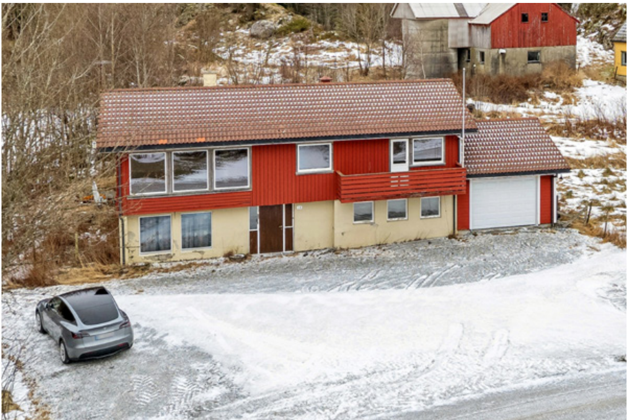
Boligen fremstår med betydelig vedlikeholdsbehov på flere bygningsdeler.
