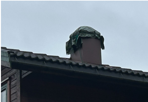
Presenning over luftehatt.
