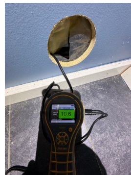
Fuktmåling i konstruksjon mot terreng
