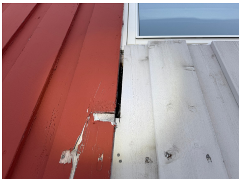
Åpning i kledning
