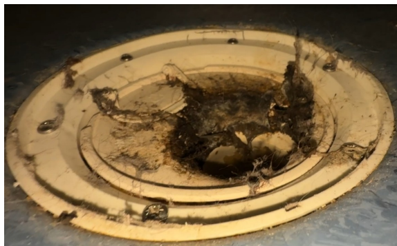
Sluk i golv under dusjkabinettet
