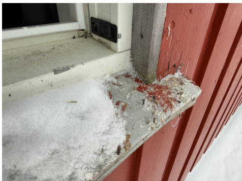
Utvendig kledning er lagt helt ned på beslaget
