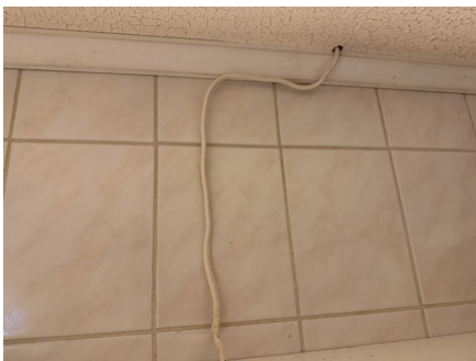
Ikke tilstrekkelig festet strømkabel.
