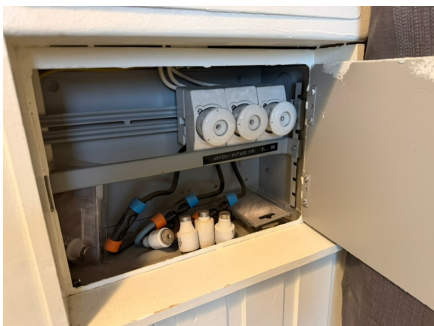
Ikke tilstrekkelig festet strømkabel.
